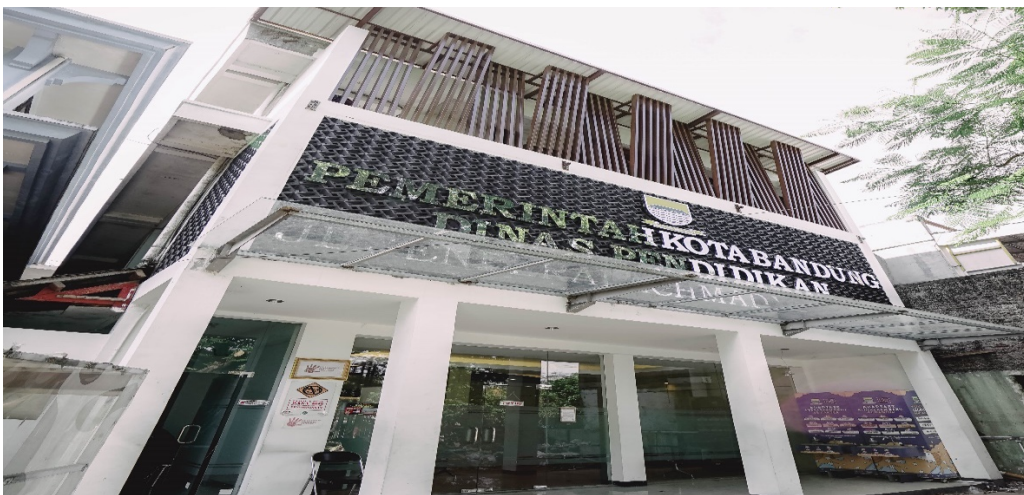
Gambar 12. Gedung Pelayanan Dinas Pendidikan Kota Bandung
